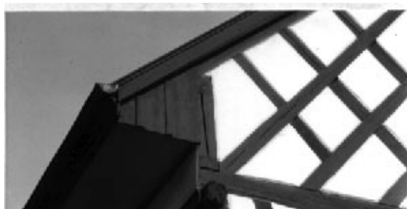
Richtig: Traufuntersicht bündig mit Giebel- fassade
