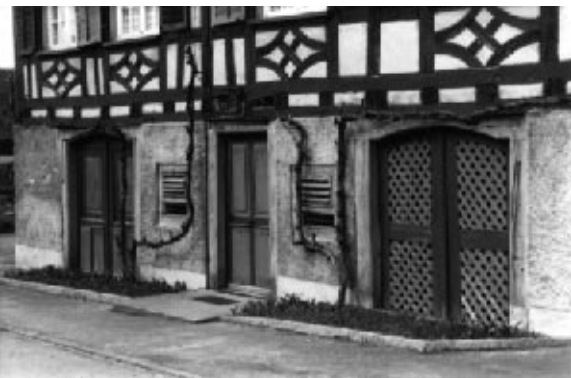
Gut: herkömmliche Türen, welche dem Charakter unserer Altbauten entsprechen
