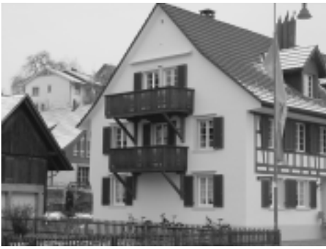
Schlecht: An Altbauten atypische Balkone am falschen Ort
