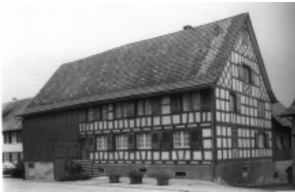
Gut: klare Gliederung der Fassade. Öffnungen berücksichtigen die Konstruktion
